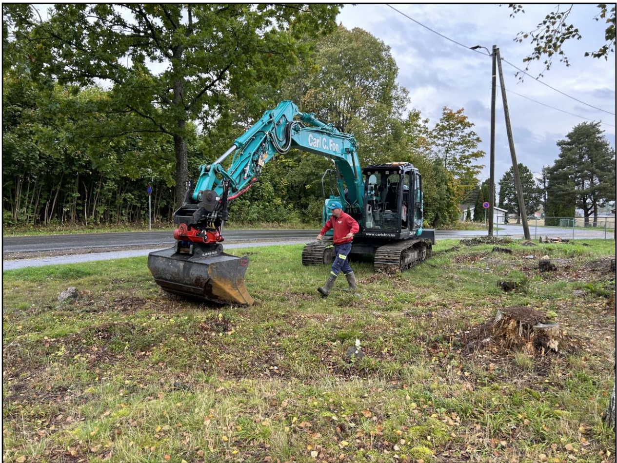
Figur 4. Maskinfører Geir Olsen under oppstart av sjakting ved Virik Idrettsplass.
